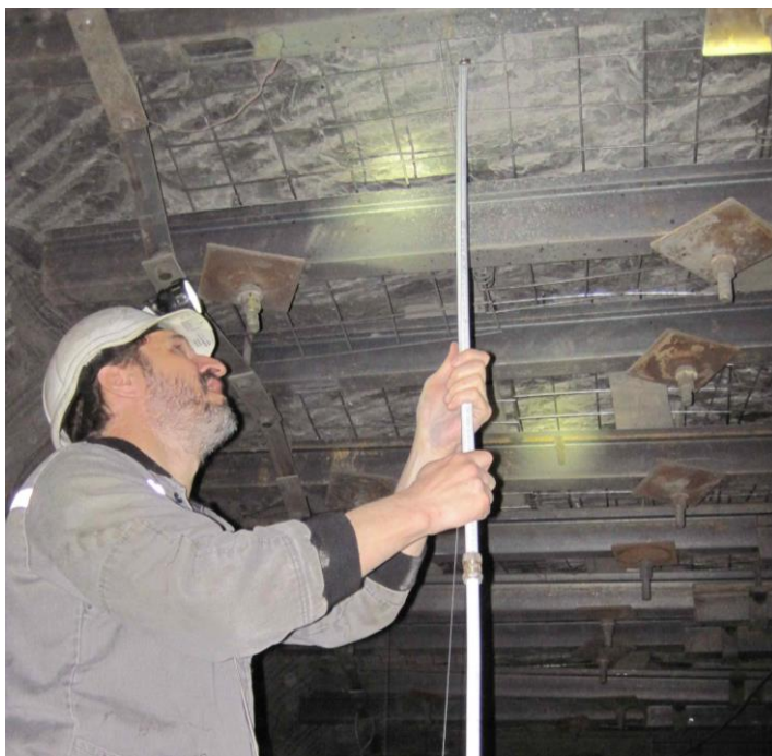
Рис. 15.11. Установка якоря в скважину
